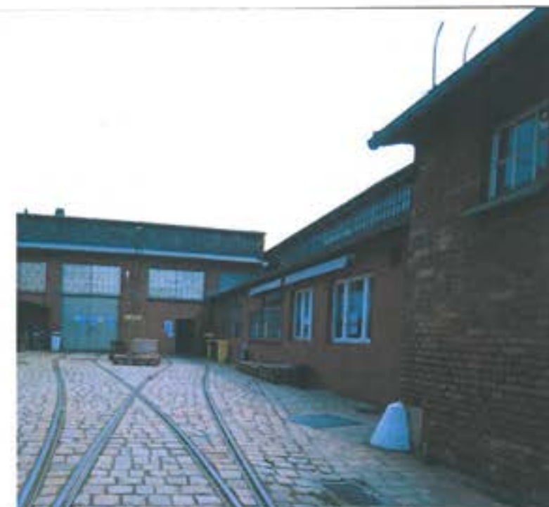
Elewacja budynku – widok w kierunku na halę postojową nr 3 – stan obecny
