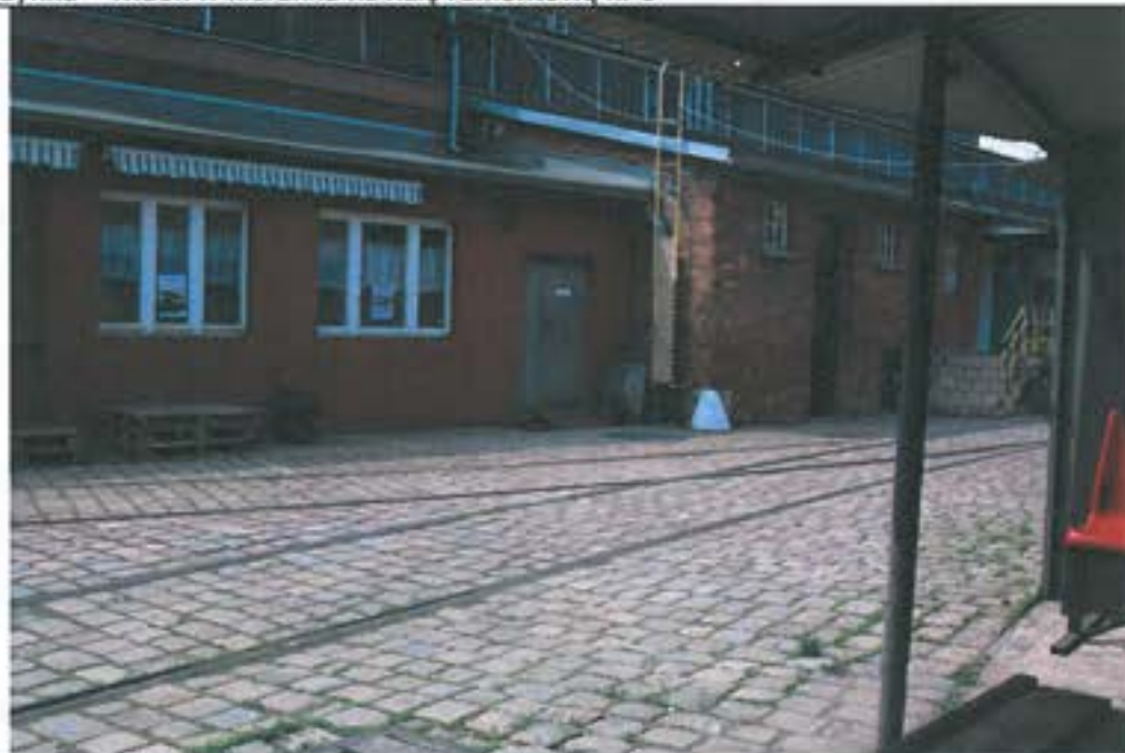
Elewacja budynku – widok w kierunku na halę postojową nr 2
